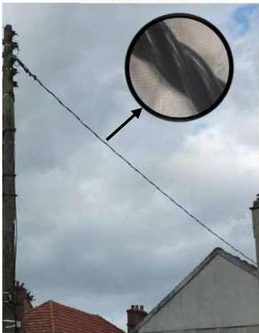
Réseau fils isolés aérien BT
