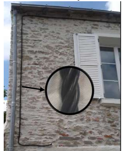
Réseau fils isolés façade BT
