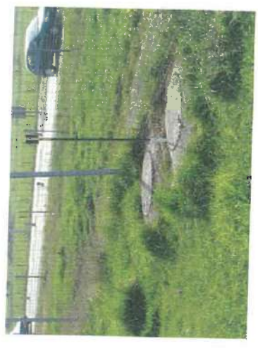
Bassin ou pré-bassin de confinement avec vanne d'obturation et volume mort dimensionné pour laisser un temps d'intervention suffisant (SETRA)
